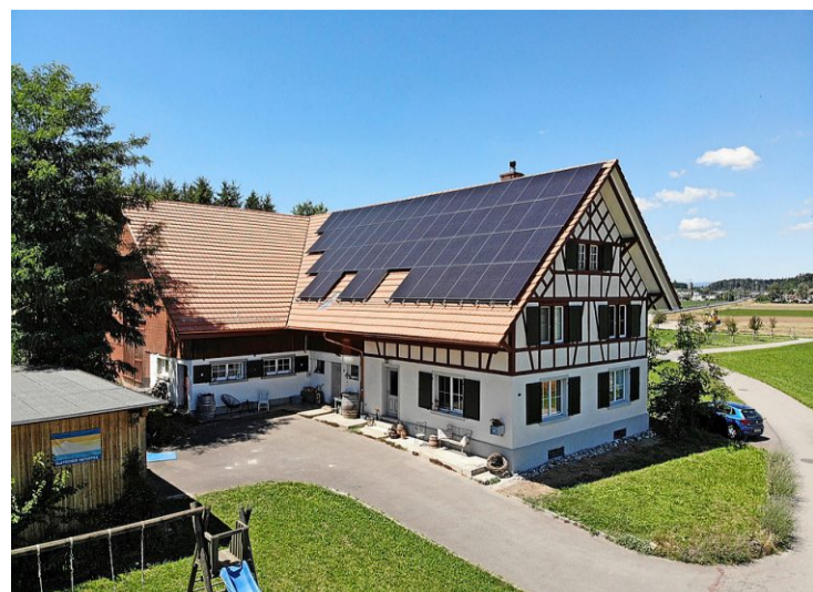
Das Dach des Riegelhauses ist durch die Ausrichtung nach Süden ideal geeignet für eine Fotovoltaikanlage.
